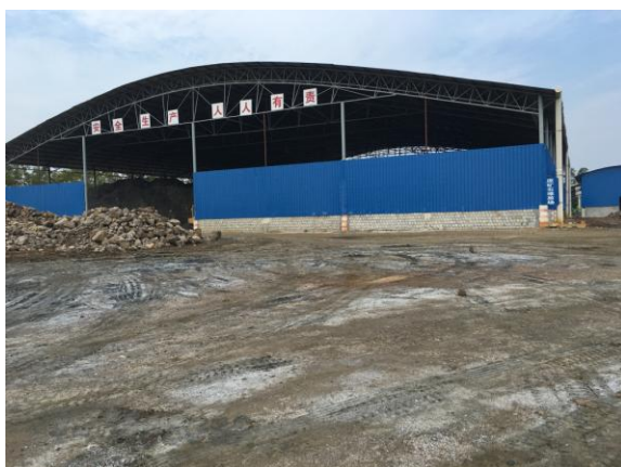
原矿堆场建设高 3m 挡风围栏
