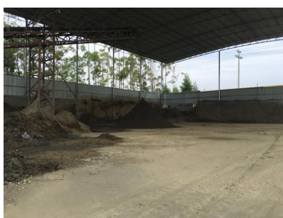
尾砂临时堆场建设高 2.5m 挡风围栏
