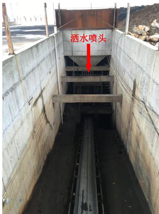
原矿石破碎及落料口自动洒水喷头
