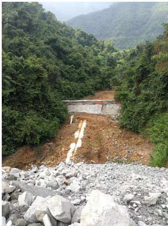
图 3-6 建成的废石场拦渣坝
