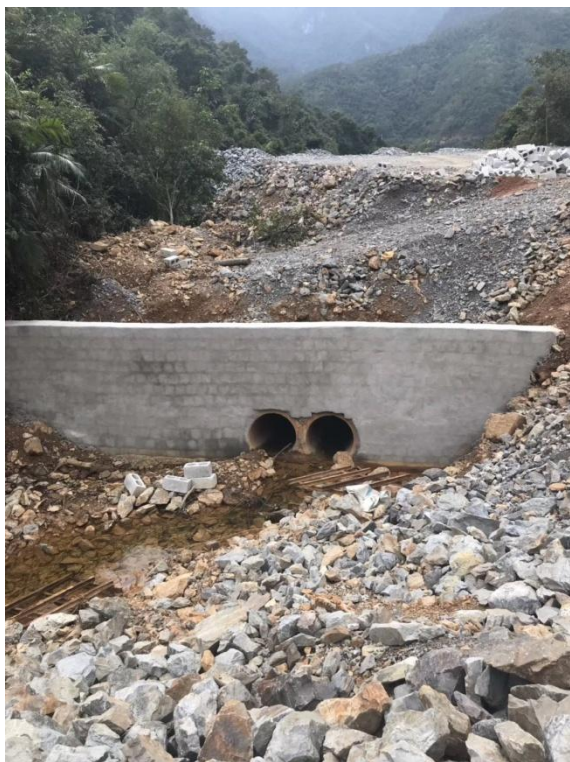
图 3-5 建成的废石场拦水坝
