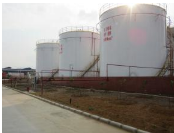
甲醇储罐区及围堰、喷淋管
