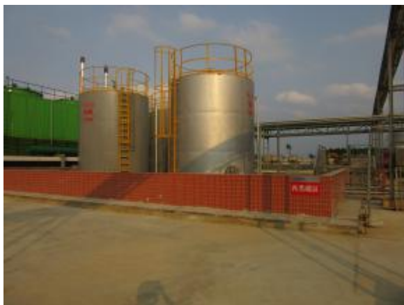
柴油、液碱、氨水储罐区及围堰、喷淋管
