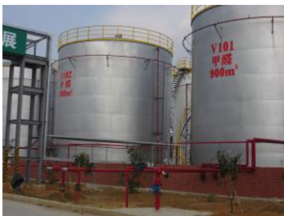
甲醛储罐区及围堰、喷淋管
