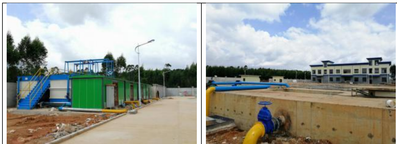
图 3.3-2 园区污水处理厂现状照片
