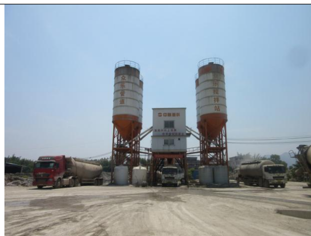
筒仓及搅拌主楼（采用脉冲布袋除尘器）
