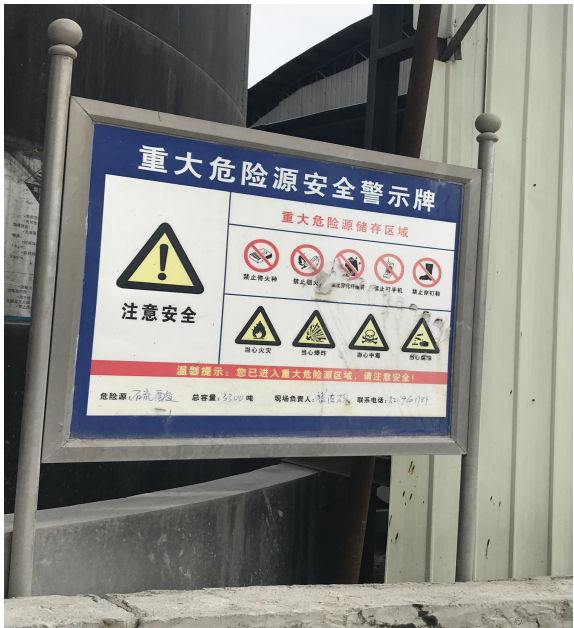
罐区围堰+警示牌
