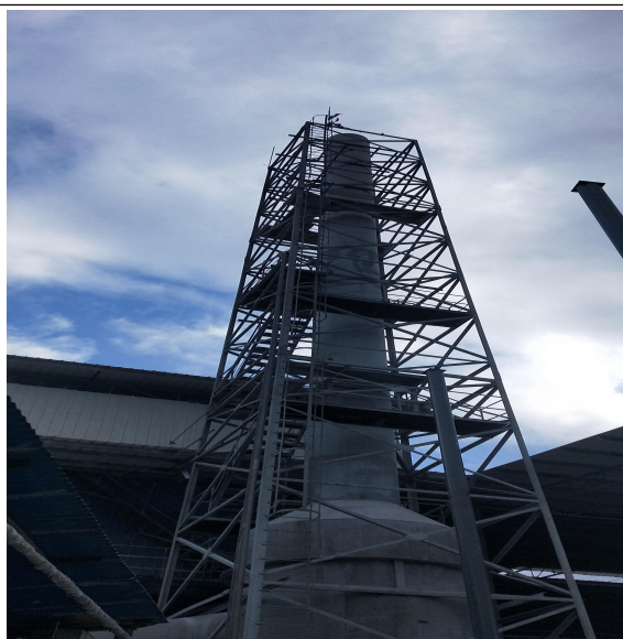
干燥系统废气排气筒
