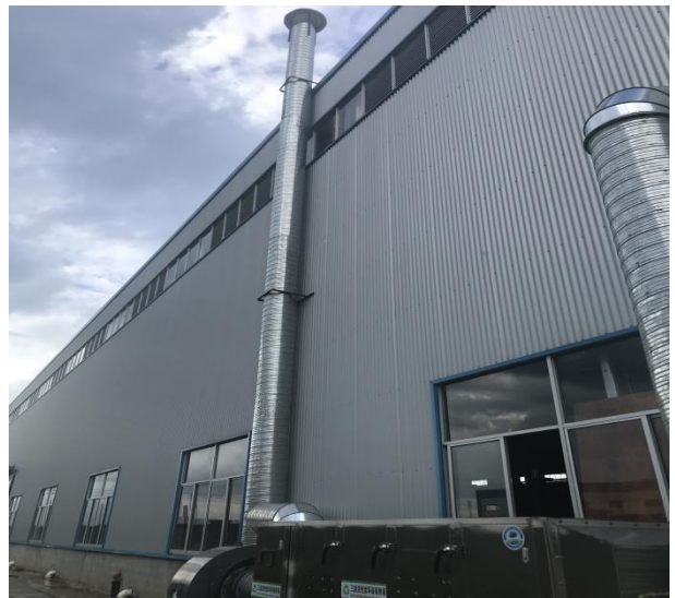
活性炭吸附装置+23m 排气筒（涂胶、热压）
