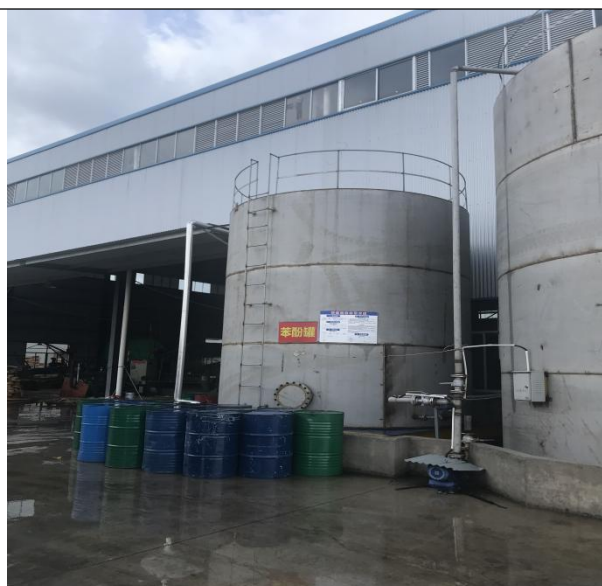
苯酚罐（制胶）+围堰
