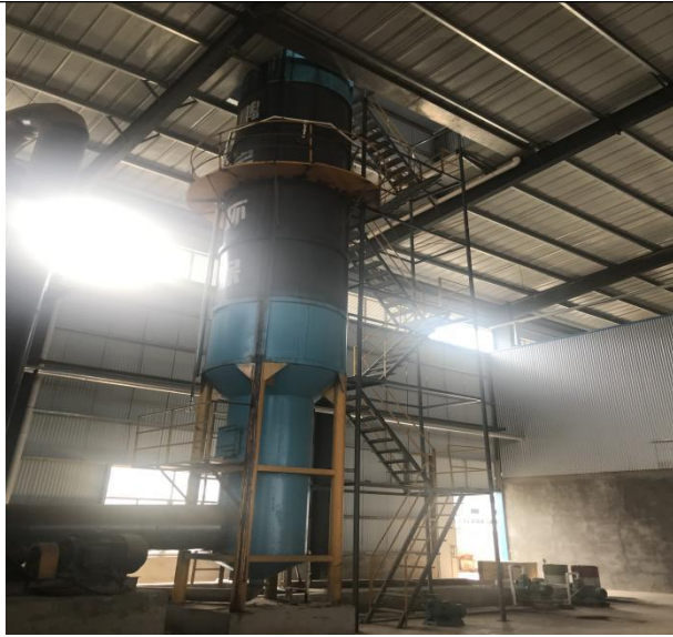
旋风+水浴除尘+15m 排气筒（锅炉烟气）
