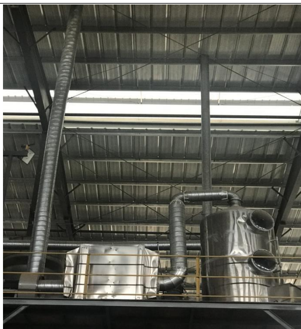
冷凝+喷淋+活性炭吸附系统+15m 排气筒（制胶）
