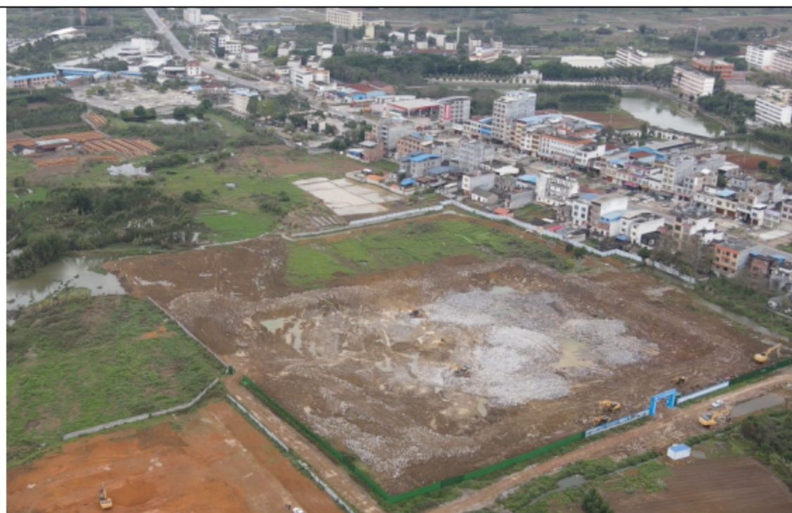
北面现状-贵港市港北区第二人民医院综合医院项目用地及大圩镇沿 G358 国道 居民区
