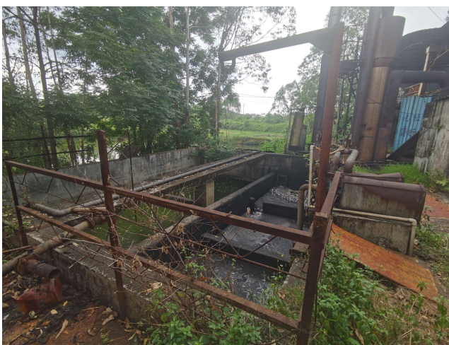
锅炉除尘水循环沉淀池
