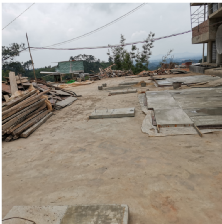
沼气池及沼液贮存池
