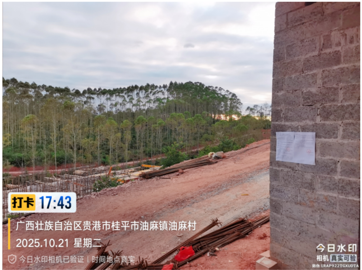
4-2 项目现场张贴公示
