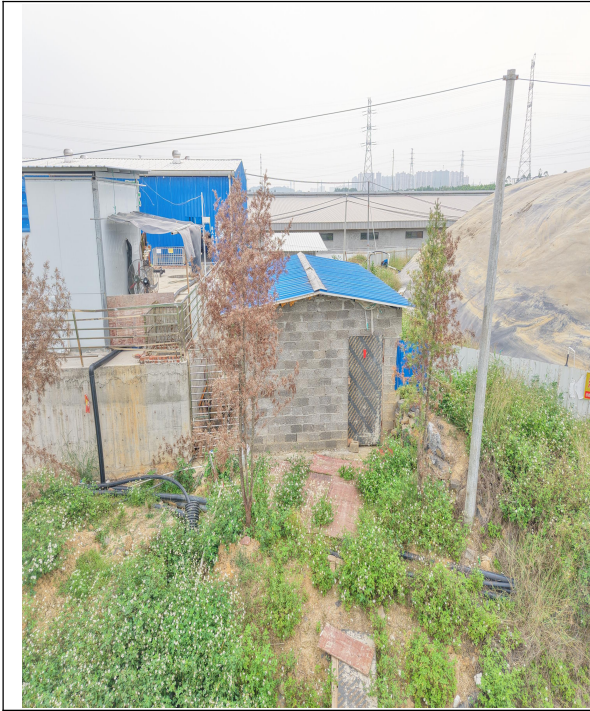
无害化处理房（病死猪暂存库）
