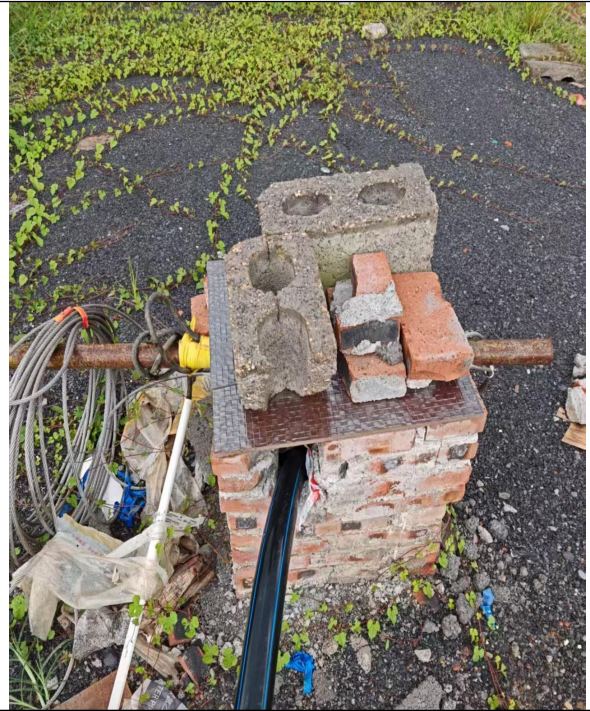
地下水监控井
