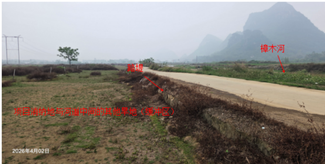
图 4.2.2-2 樟木河沿河道路情况图
